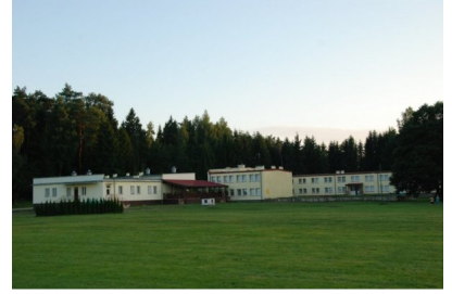
Widok ogólny budynków w ośrodku w Strępielku
